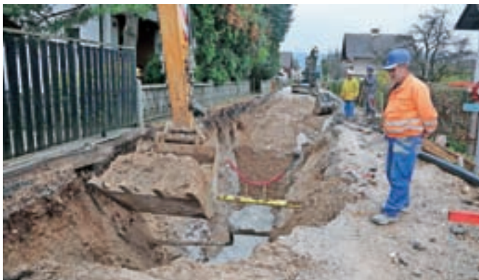
Gradnja kanalizacije v naselju Breg
